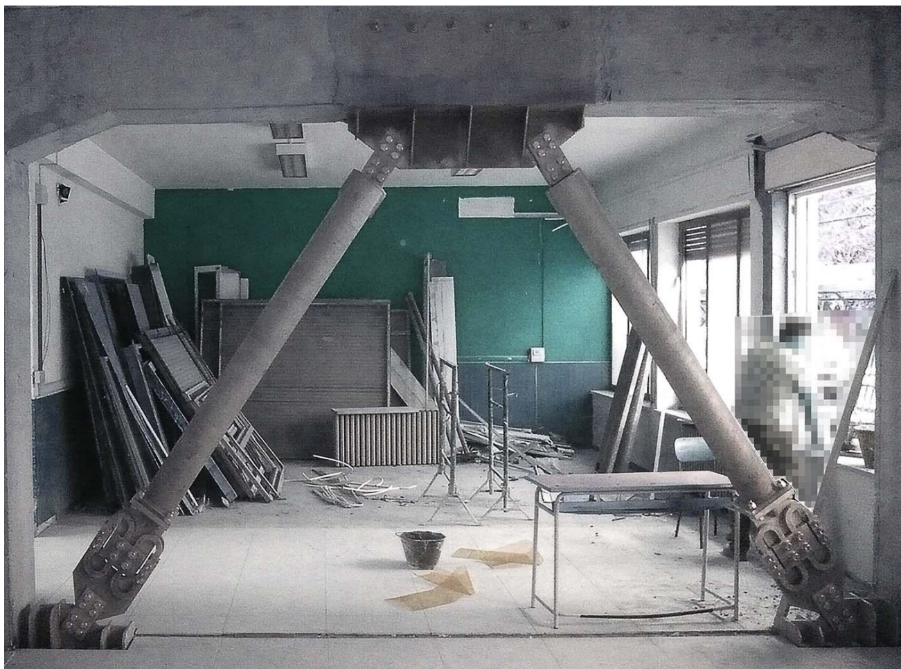
Installazione di controventi dissipativi
